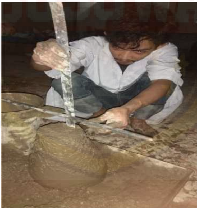
Pengukuran nilai slump
