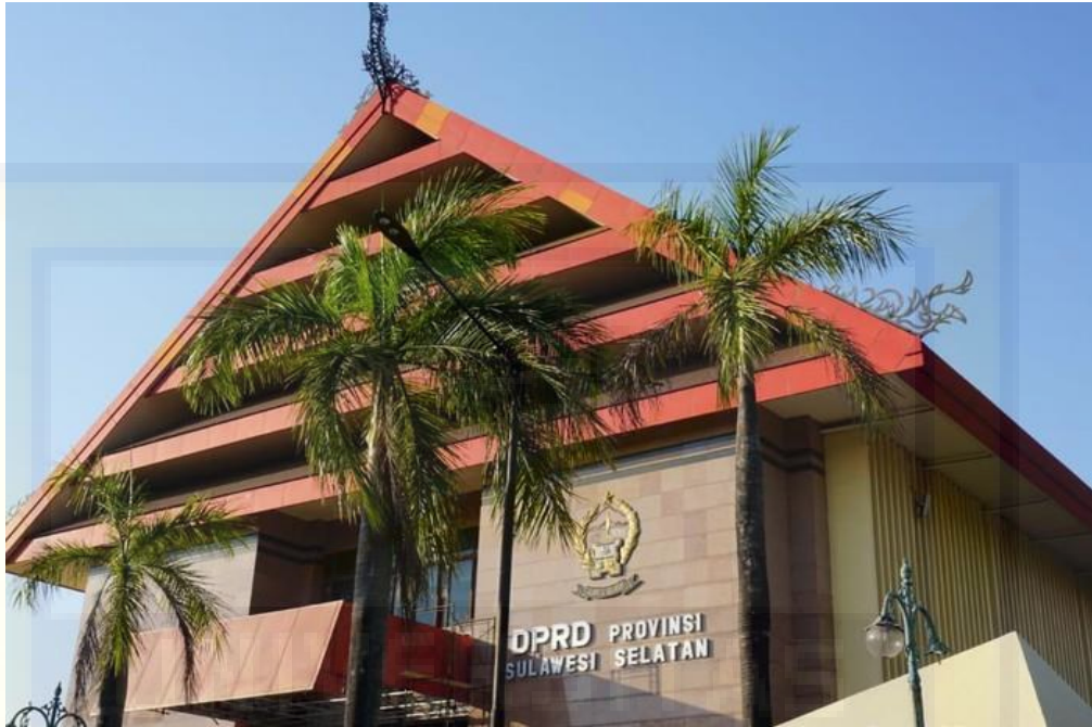
Gambar 3 Gedung Kantor DPRD Provinsi Sulawesi Selatan
