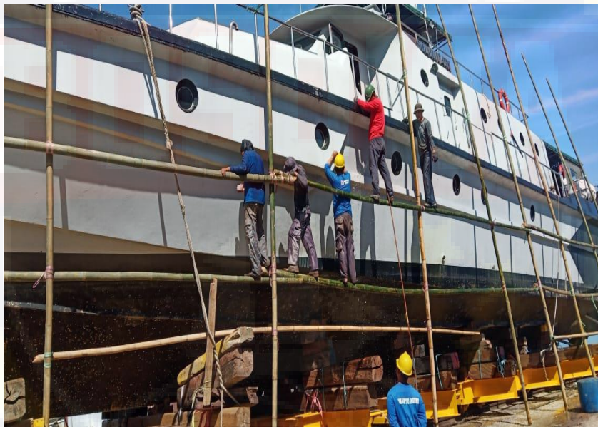
Persiapan Pengecatan Kapal
