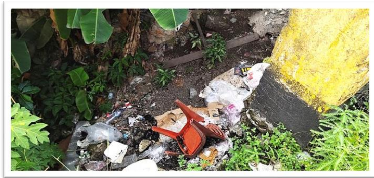
Gambar 3.6. Sampah yang dibuang ke kolong jembatan (sumber: survei thn 2019)
