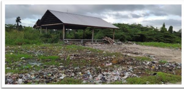
Gambar 3.12. Fasilitas bangunan di TPA Wanggar Makmur (sumber: survei thn 2019)
