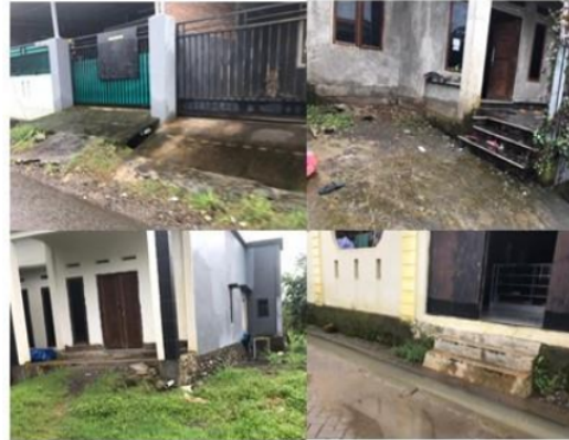
Gambar 6 Rumah Penduduk di Desa Jenetallasa dengan Meninggikan Pondasi Rumah
