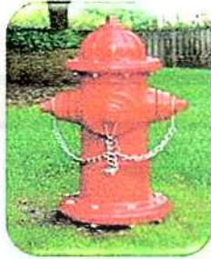
Gambar 3. 20 : Water Hydrant (Sumber : www.google.com )
