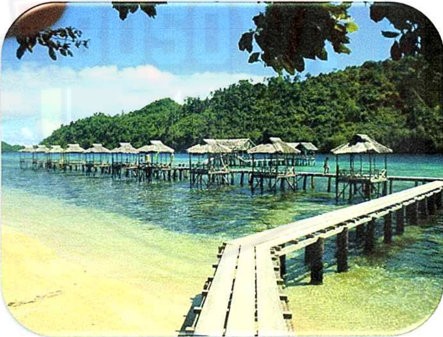
Gambar 3.8 : Kondisi Bangunan Wisata Alam Lestari Pantai Bongo (Sumber : Data Survey, Diolah 17 Novmber 2016 )
