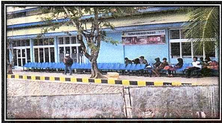
Gambar 4.5 Ruang Tunggu Penumpang Pelabuhan Murhum
