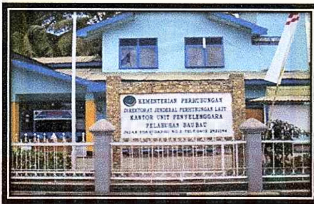
Gambar 4.7 Kantor UPP Pelabuhan Murhum
