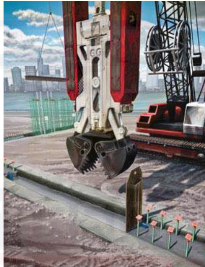
Gambar 3.4 Sketsa Penggalian menggunakan mesin grab
