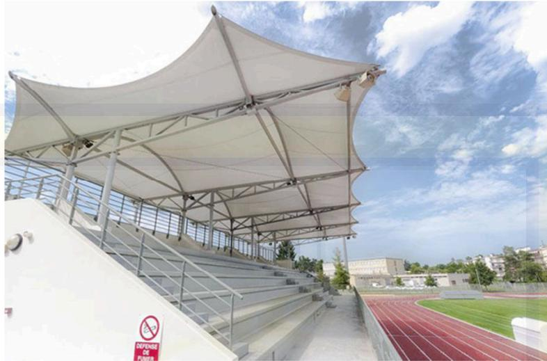
Gambar 5.13 : Struktur Membran
