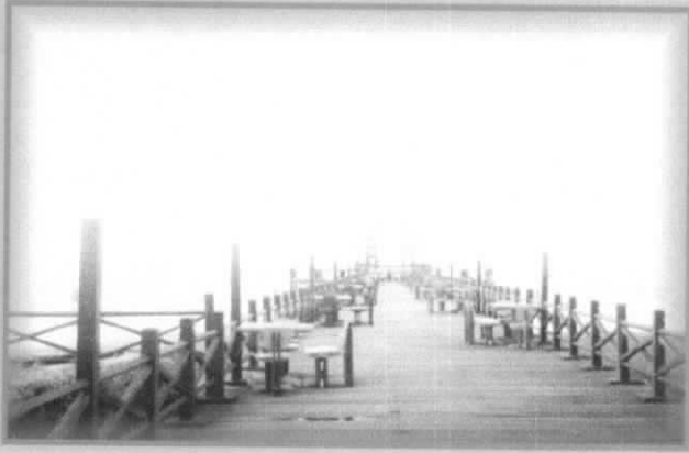
Dermaga kayu di tepi pantai Akkarena yang dilengkapi dengan tempat duduk untuk bersantai bagi pengunjung yang datang ke lokasi wisata pantai Akkarena Tanjung Merdeka.
