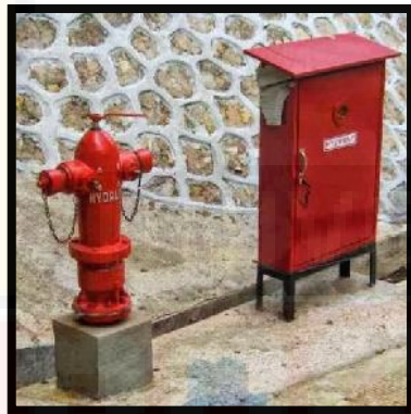
Gambar 6.31 : Hydrant Outdoor dan Cabinet, Jarak Tiap Hydrant Sumber : (firehydrant.id, akses mei 2021)
