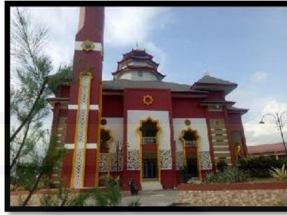
Gambar 2.15 : Masjid Cheng ho di Kompleks Sekolah Alam Bososwa (Sumber : Dokumentasi Pribadi, Oktober 2020)
