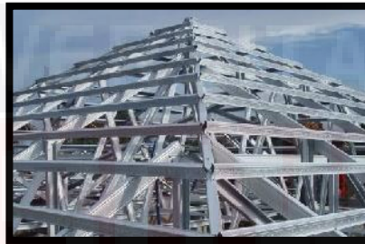
Gambar 6.12 : Rangka Baja Ringan (sumber : google.com)
