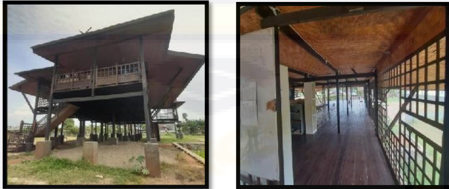
Gambar 2.18 : Fisik Bangunan Utama III dan Interior Ruangan
