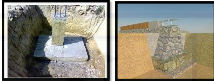
Gambar 6.17 : Pondasi Poer Plat (kiri) dan Batu Kali (kanan) (sumber : google)
