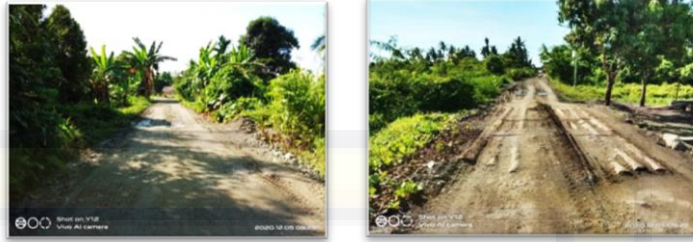
Gambar 4.19 Kondisi Jaringan Jalan (Sumber : Survei Lapangan Tahun 2020)
