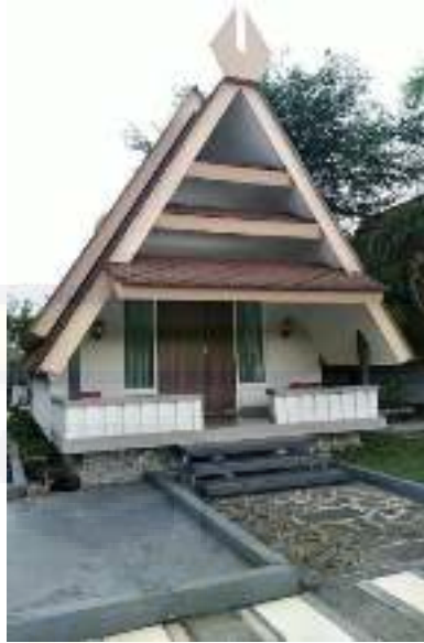
Gambar 2.49 : Tampak Standar Room Sumber: dokumentasi Pribadi, April 2021
