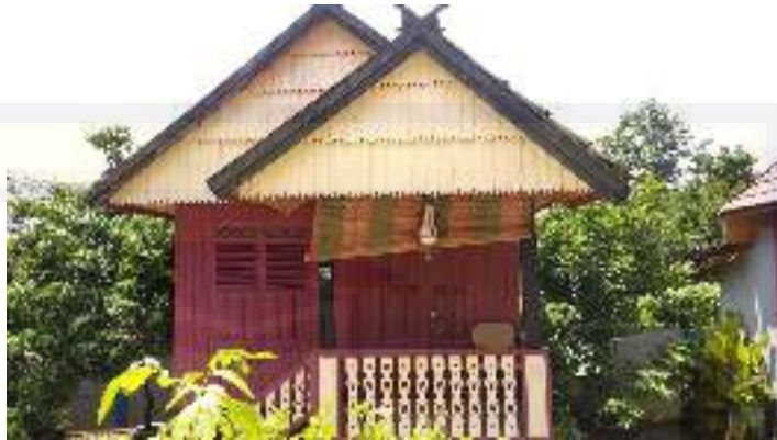
Gambar 2.65: Tampak Depan Small Cottage Permata Indah Resort Sumber: Dokumentasi Pribadi, April 2021
