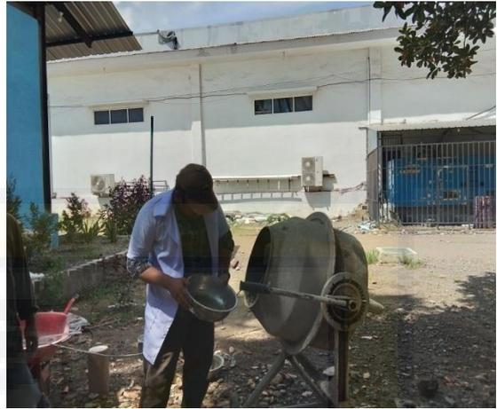
**Proses mencampur seluruh agregat penyusun beton**
