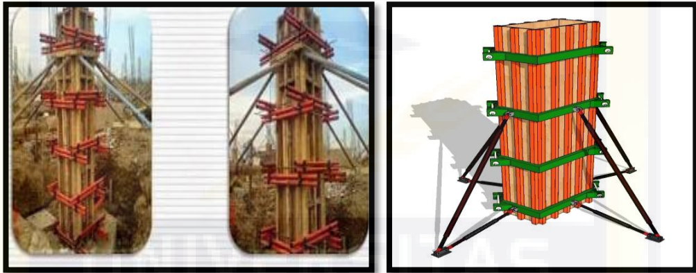
Gambar 2.2 Bekisting Semi Sistem (Baja Profil)
