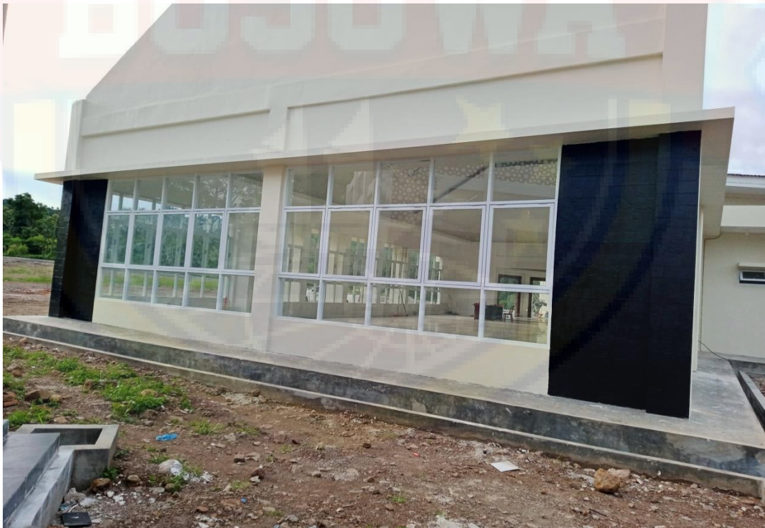
Gambar Tampak Samping Kiri Usaha Mikro Kecil Menengah Rest Area
