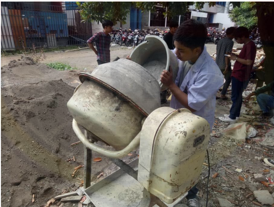
Proses Pembuatan Campuran Beton
