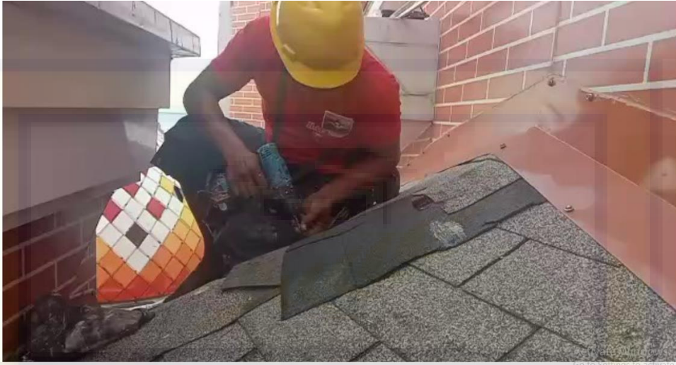
Pekerjaan Atap Mesjid
