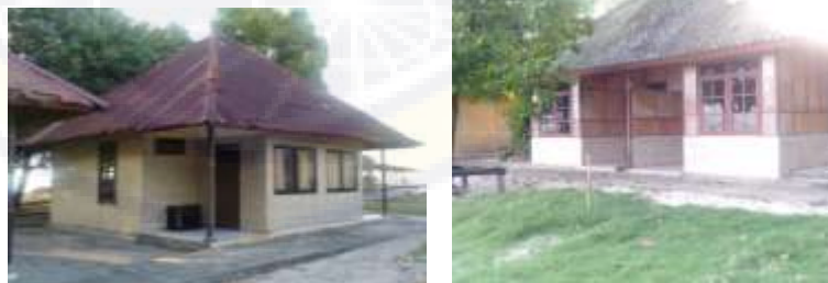
Gambar 2.54 Penginapan di Pulau Khayangan
