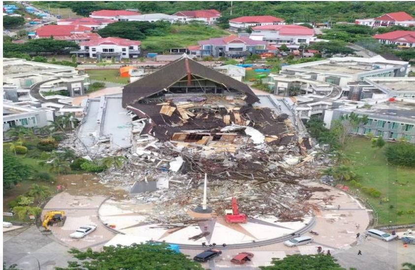
Gambar 7. Kondisi Kantor Pasca Gempa
