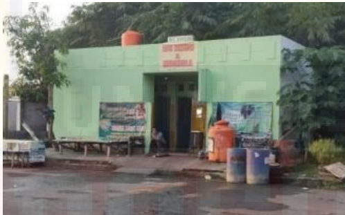
Gambar 2.33: Wc Umum & Mushollah Sumber : https://lib.unnes.ac.id
