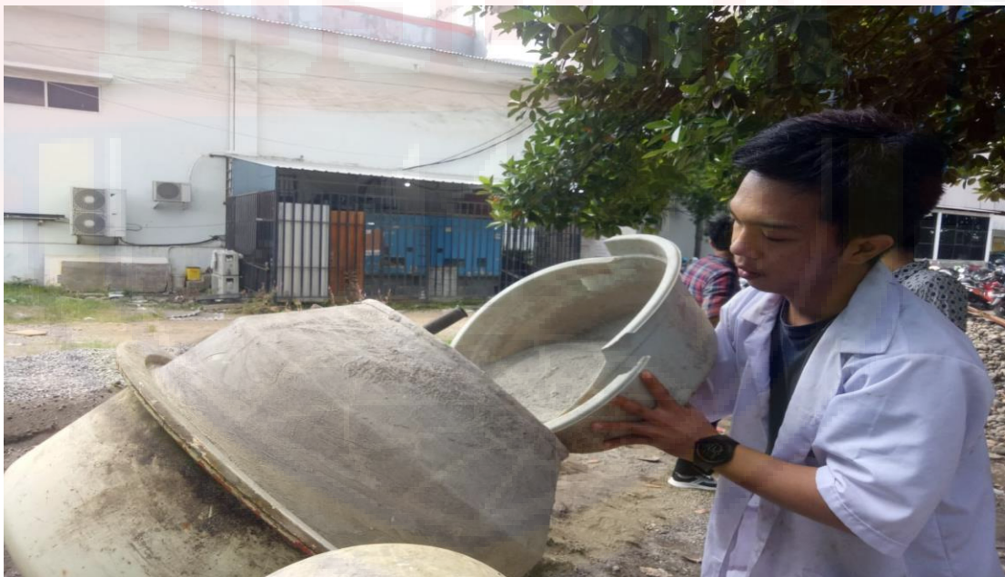
Proses Pembuatan Campuran Beton
