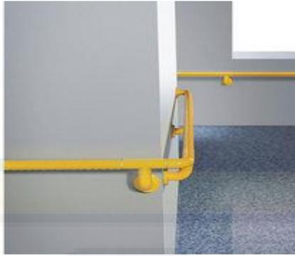
Gambar II.16 : Alat bantu pipa pegangan di Panti Jompo
