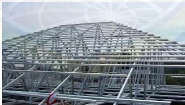
Gambar IV.5 : Rangka atap baja ringan sebagai *upper struktur* Panti Werdha
