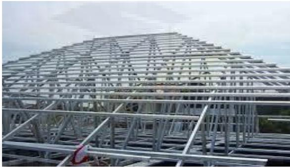
Gambar III.16 : Rangka atap baja ringan sebagai upper struktur
