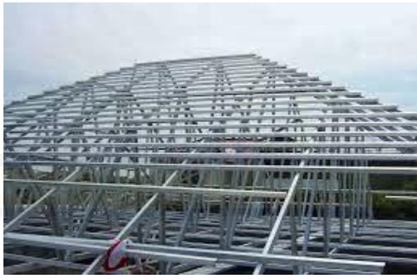
Gambar V.14 : Struktur atas (rangka baja ringan)
