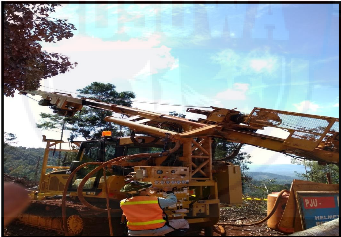
Proses Drilling untuk pengambilan sampel
