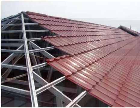
Gambar 5.26 : konstruksi atap baja ringan sumber : google, 2021)
