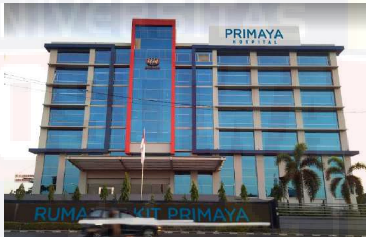
Gambar 2.23 : primaya hospital Sumber : ola data juni 2021
