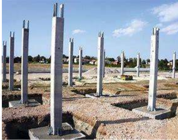
Gambar 5.23: pekerjaan pondasi telapak sumber : google, 2021)
