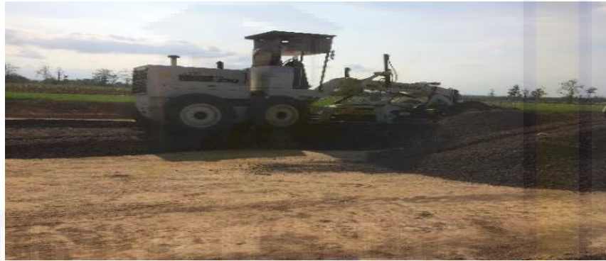
Gambar 3.5 Perataan Timbunan Dengan Motor Grader
