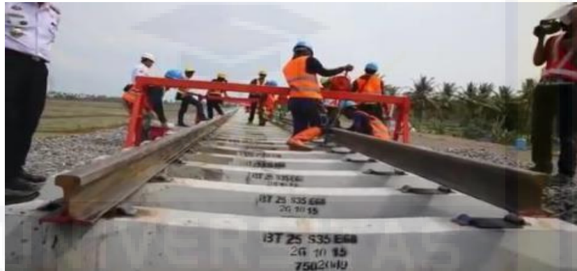
Gambar 3.11 Pemasangan Rel
