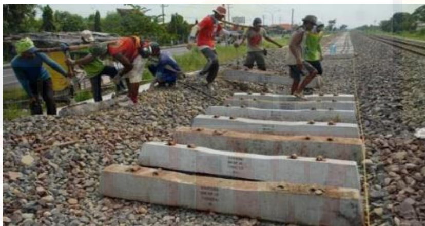
Gambar 3.10 Pemasangan Bantalan
