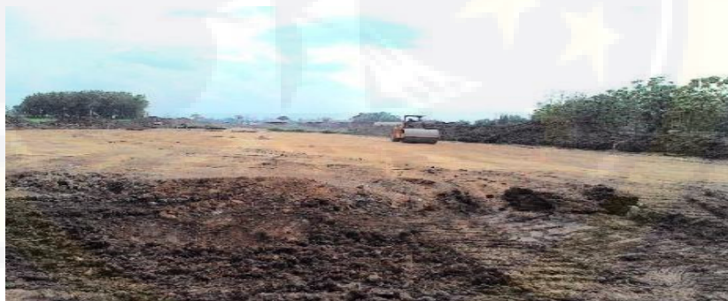
Gambar 3.3 Pemadatan Dengan Tandem Roller
