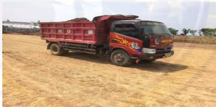
Gambar 3.4 Pengangkutan Material Timbunan Dengan Dump Truck
