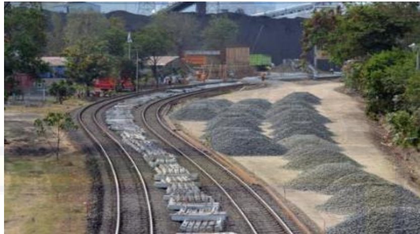
Gambar 3.7 Tumpukan Material Balas
