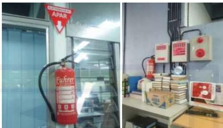
Gambar 2.74 Tabung Pemadam Api dan Fire Alarm Sistem
