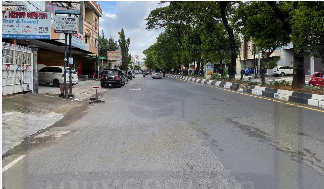
Gambar 4.67 Lokasi pada STA 1+500 – STA 1+600 yang memerlukan marka.
