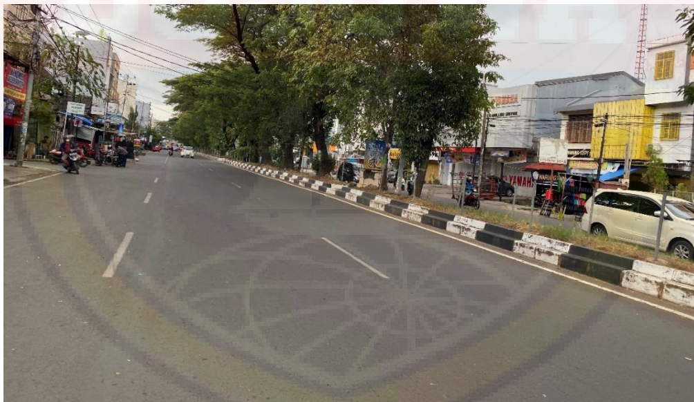
Gambar 4.61 Lokasi pada STA 0+100 – STA 0+200 yang memerlukan marka. (Normal) (Sumber : Dokumen Survey)
