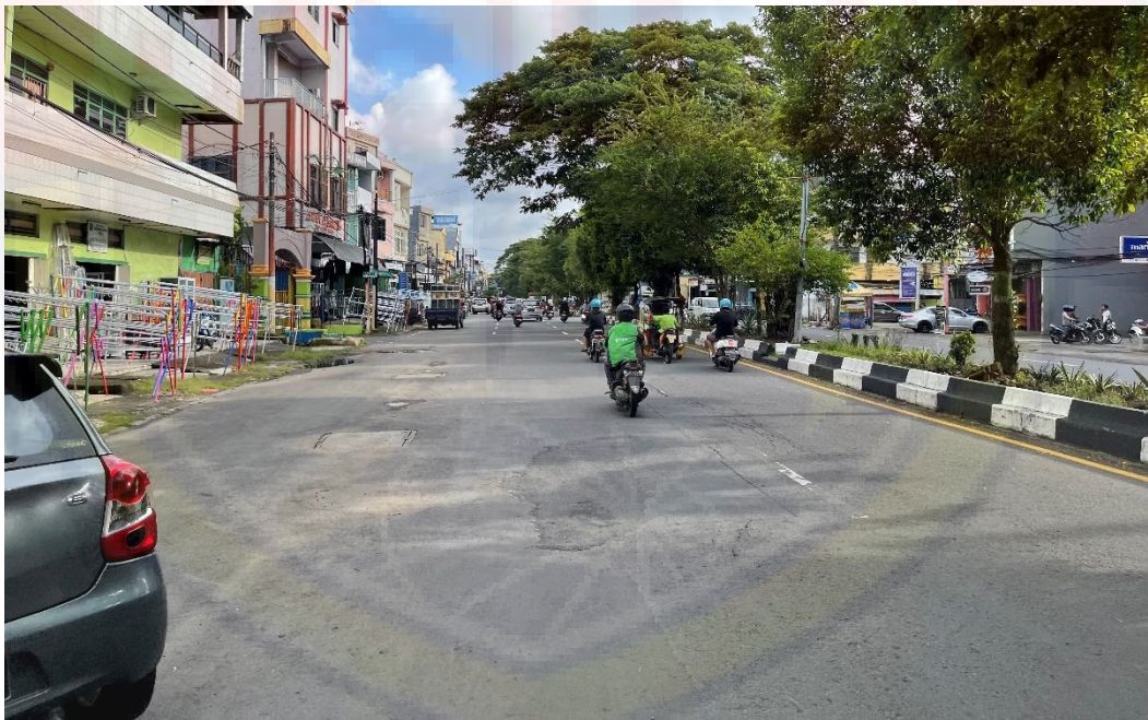
Gambar 4.76 Lokasi pada STA 3+150 – STA 3+350 yang memerlukan marka. (Opposite) (Sumber : Dokumen Survey)
