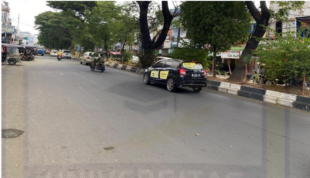
Gambar 4.57 Lokasi pada STA 0+200 – STA 0+300 yang memerlukan marka.
