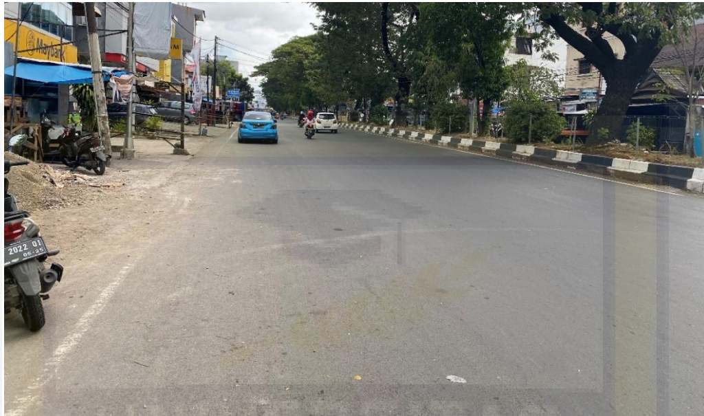
Gambar 4.55 Lokasi pada STA 0+000 – STA 0+100 yang memerlukan marka. (Opposite) (Sumber : Dokumen Survey)
