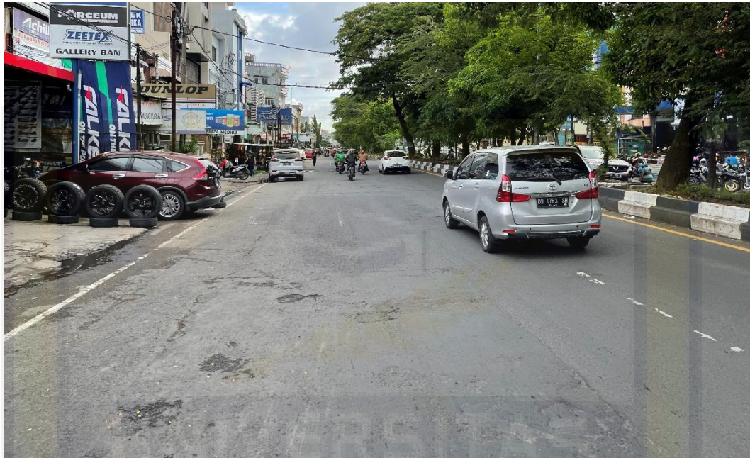
Gambar 4.69 Lokasi pada STA 1+700 – STA 1+800 yang memerlukan marka.
