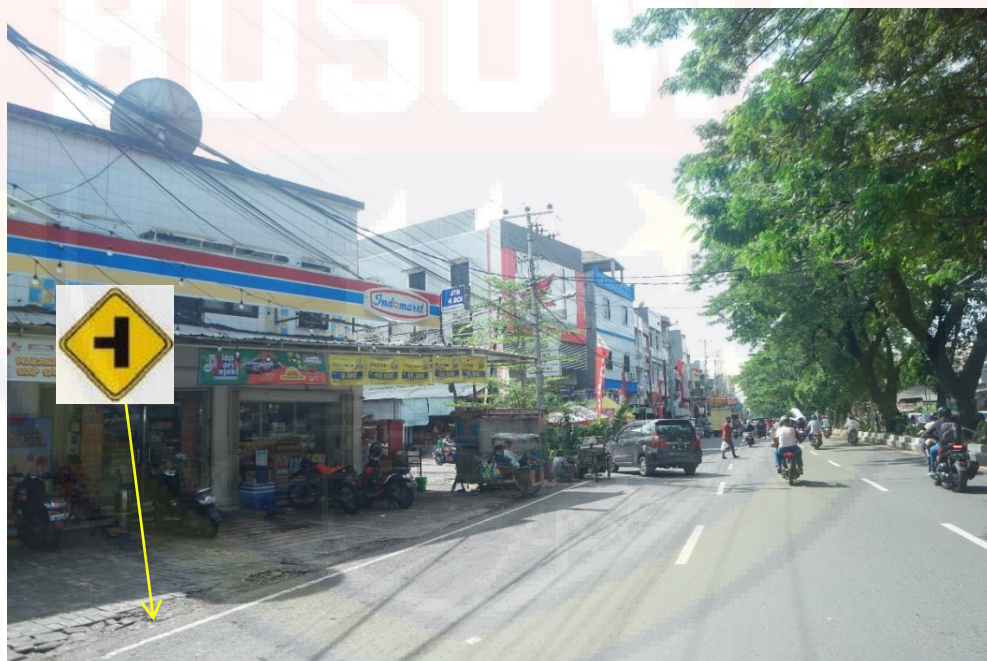
Gambar 4.46 Lokasi simpang tiga Jl. Sungai Limboto yang membutuhkan pemasangan rambu peringatan simpang tiga sisi kiri. (Normal) (Sumber : Dokumen Survey)
