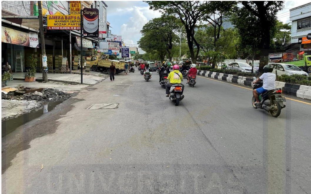
Gambar 4.73 Lokasi pada STA 2+300 – STA 2+500 yang memerlukan marka.
