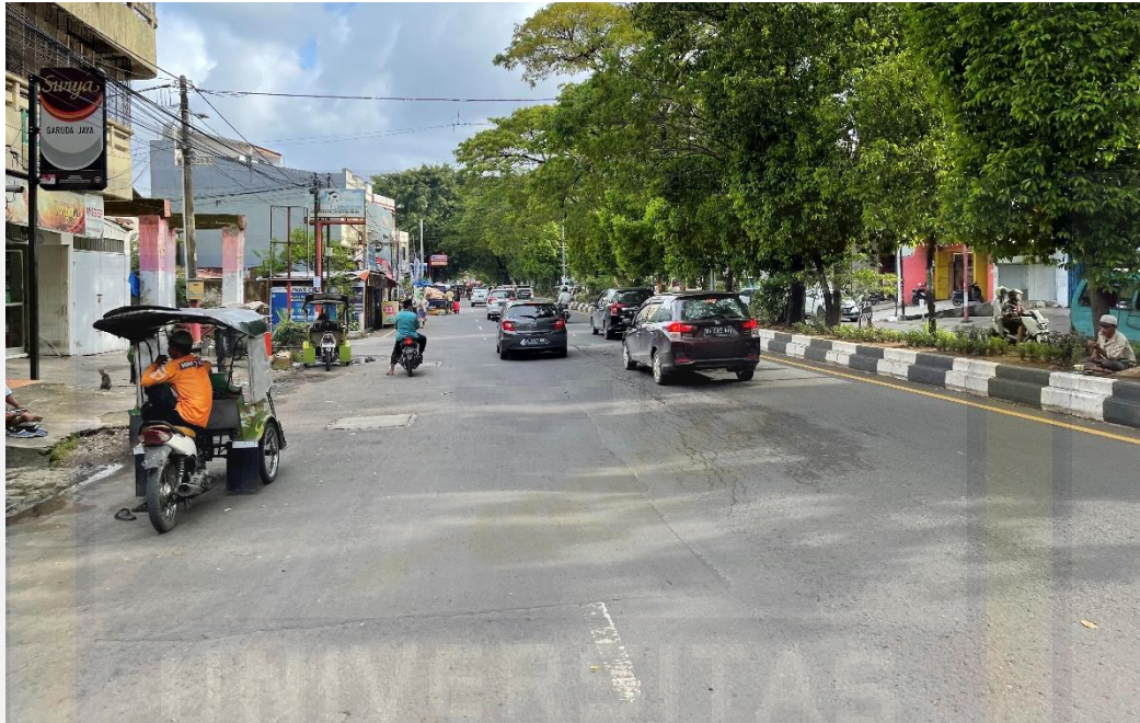
Gambar 4.75 Lokasi pada STA 3+000 – STA 3+150 yang memerlukan marka. (Opposite) (Sumber : Dokumen Survey)
