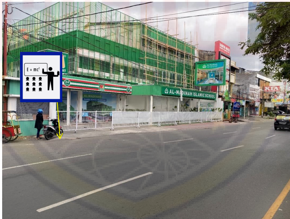
Gambar 4.52 Lokasi didepan Al-Madiyah Islamic School yang memerlukan pemasangan rambu petunjuk tempat belajar mengajar. (Opposite)
