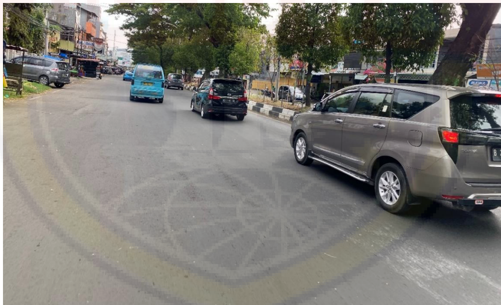
Gambar 4.56 Lokasi pada STA 0+100 – STA 0+200 yang memerlukan marka. (Opposite) (Sumber : Dokumen Survey)
