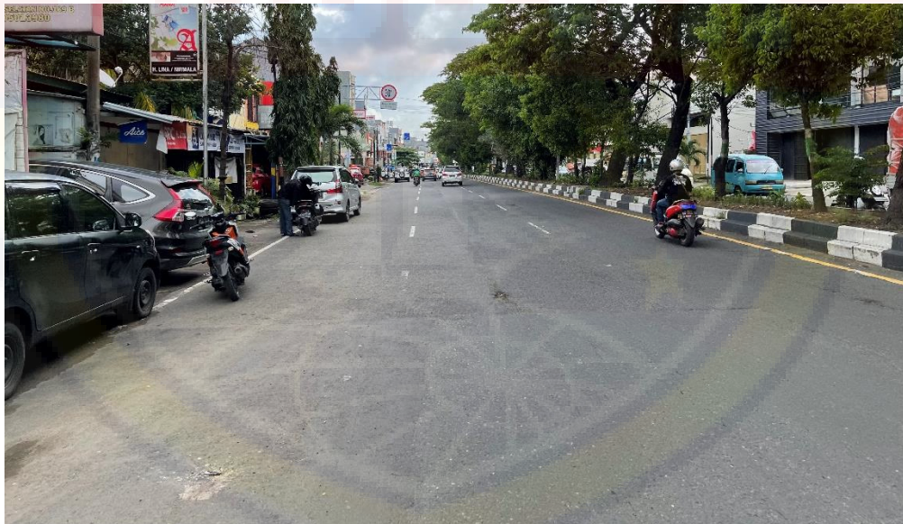
Gambar 4.66 Lokasi pada STA 1+400 – STA 1+500 yang memerlukan marka.
