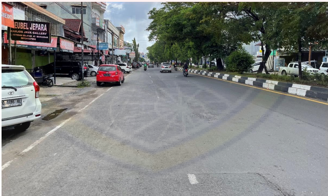
Gambar 4.68 Lokasi pada STA 1+600 – STA 1+700 yang memerlukan marka.
