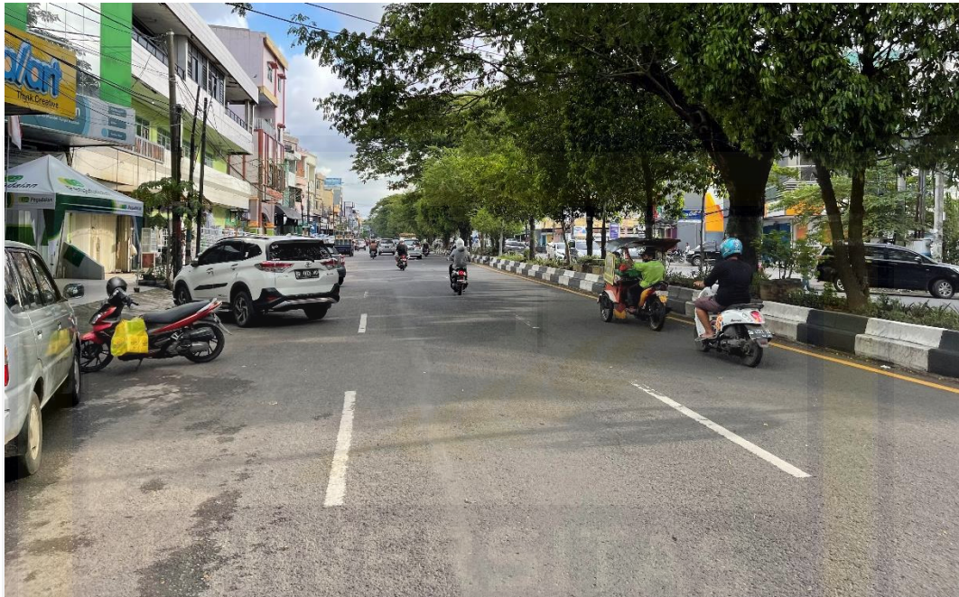
Gambar 4.77 Lokasi pada STA 3+350 – STA 3+500 yang memerlukan marka.
