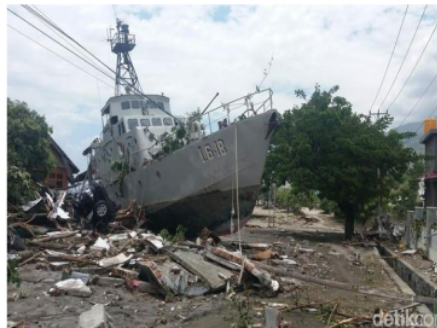
Gambar 3. Kondisi Dermaga Lanal Palu setelah terjadi Tsunami (Sumber: DetikNews, 2018)
