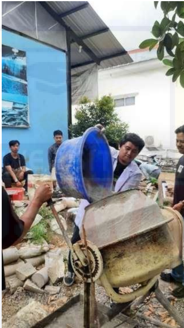
Proses pencampuran beton
