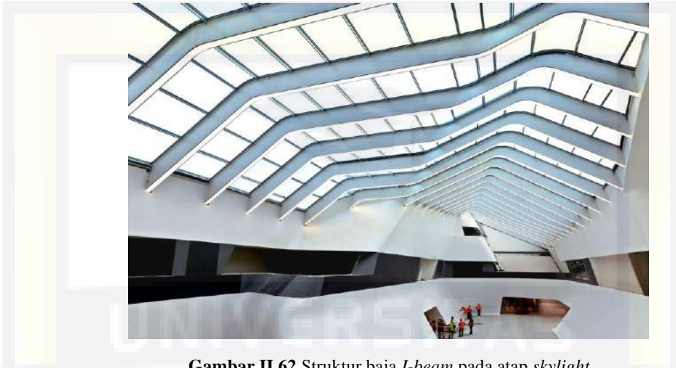
Gambar II.62 Struktur baja I-beam pada atap skylight
