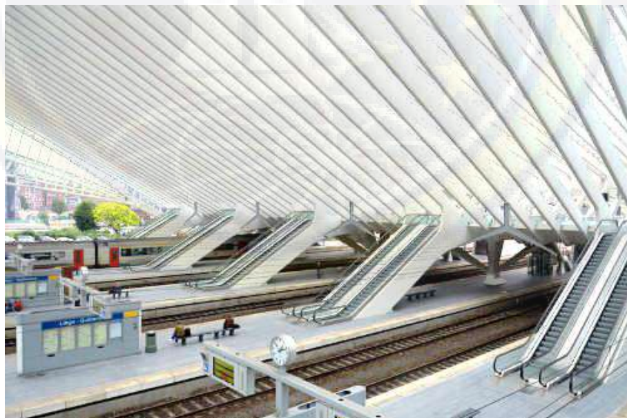
Gambar II.71 Area peron dengan jembatan penyebrangan
