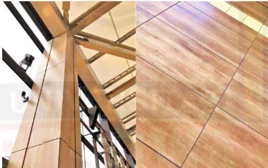
Gambar II.53 Elemen kolom dan lantai peron berlapis kayu pada stasiun Takanawa
