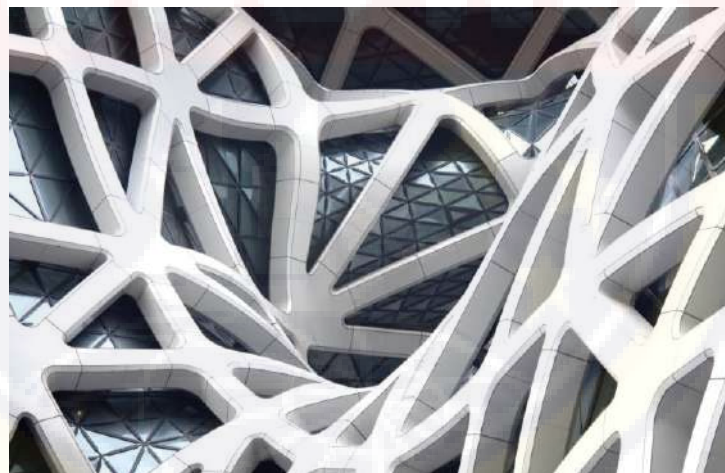
Gambar II.41 Expose struktur pada fasad Morpheus Hotel
