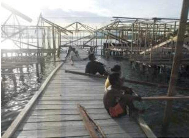
**Foto h.** Pekerja dari para pemukim di pulau Kabalutan mengamati beberapa unit rumah yang telah dipasang rangka balok pada bagian atap rumah
