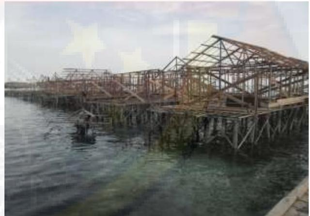
**Foto k.** Deretan rumah contoh (*prototype*) sebagai bagian dari perluasan areal permukiman tradisional suku Bajo di Kabalutan telah dipasang rangka atap
