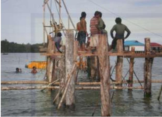
**Foto d.** Pemasangan balok skoring (kayu *Pingsan*) pada tiang jembatan, berdiameter antara 15 hingga 25 cm serta memiliki panjang antara 300 hingga 400 cm
