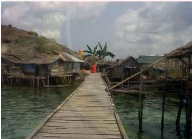
**Foto f.** Titian yang menjadi jembatan penghubung seluruh unit rumah di pesisir pulau Kabalutan telah dirampungkan, dimensi bangunannya selebar 170 cm
