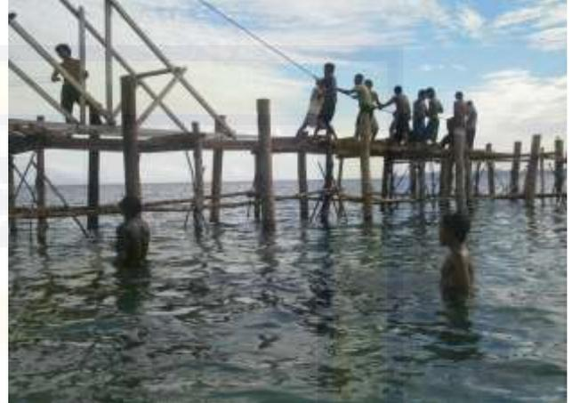
**Foto e.** Pemancangan tiang jembatan secara komunal dengan peralatan sederhana. Nantinya jembatan menjadi jalan penghubung seluruh areal permukiman
