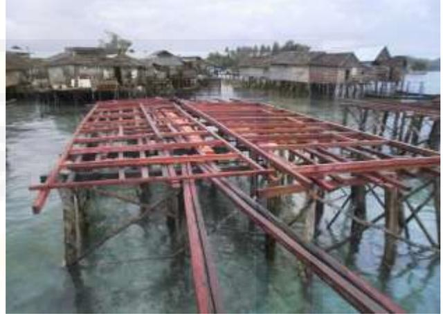
**Foto i.** Rangka balok pada lantai rumah telah dipasang di atas pondasi kayu pancang, berlatar belakang permukiman suku Bajo yang telah dibangun sebelumnya
