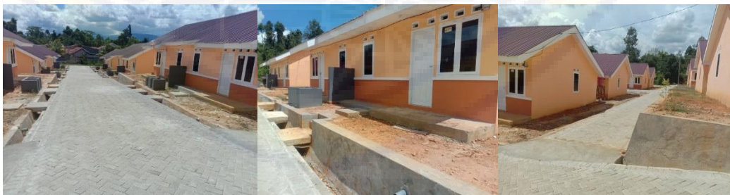
Gambar 4.11 Pembangunan Hunian Tetap Korban Bencana Banjir Bandang
