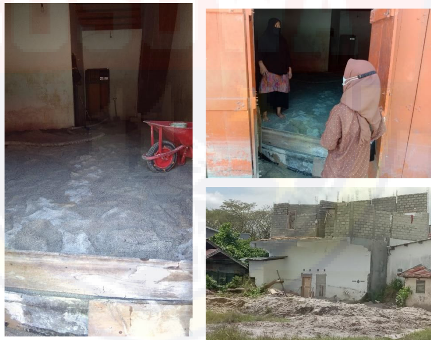
Gambar 4.10 Perbaikan Kawasan Permukiman Pasca Bencana Banjir Bandang
