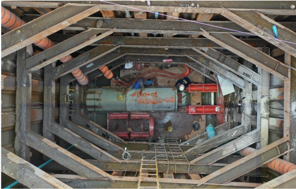
( Proses Pemasangan Instalansi pipa)
