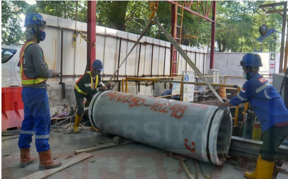
(Proses Pemasangan Instalasi pipa)
