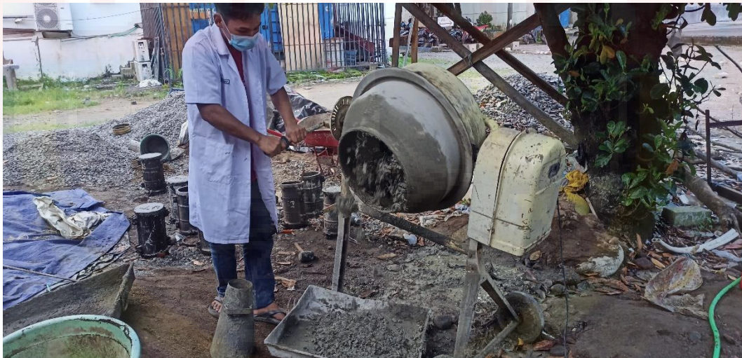
Proses Pembuatan Campuran Beton
