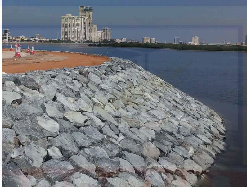
Gambar 2.2 Revetment (Pelindung Pantai)
