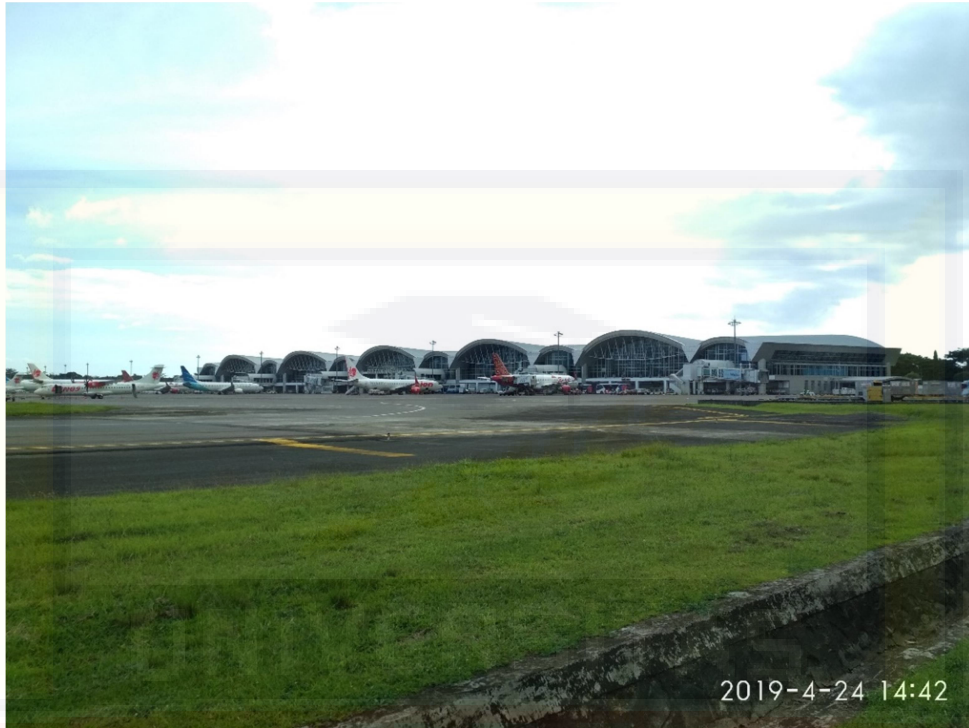
Gambar 5 Apron bandara Sultan Hasanuddin tampak dari sisi Taxiway
