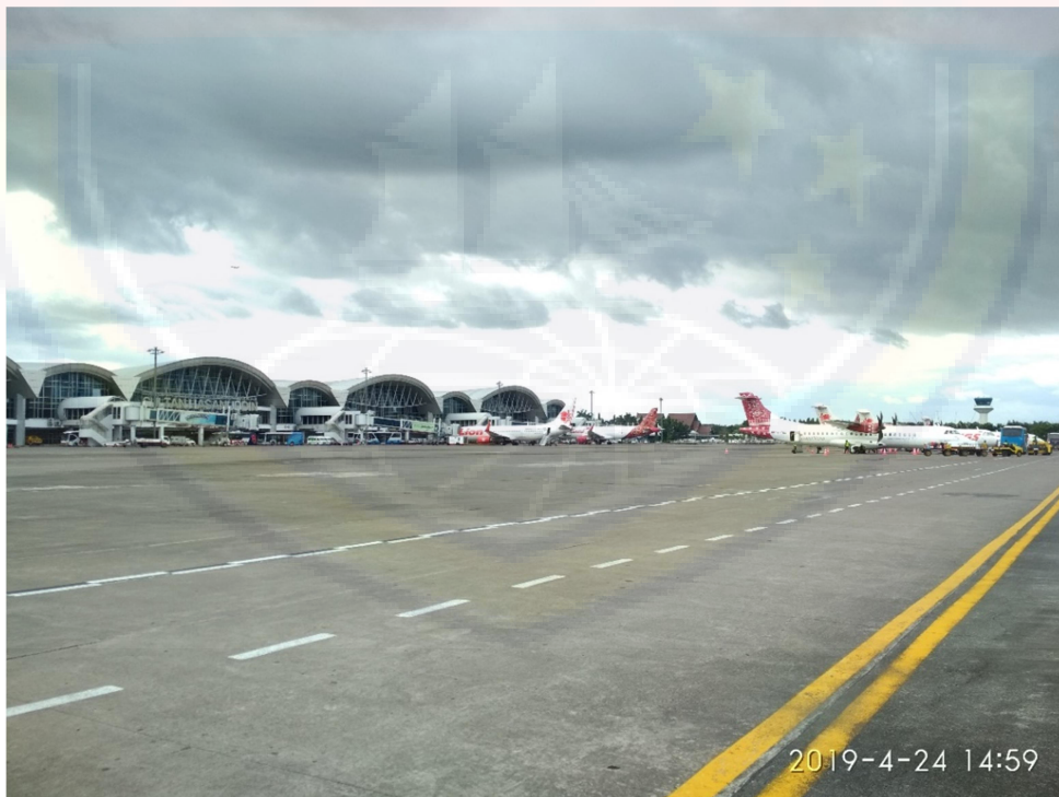
Gambar 4 Apron bandara Sultan Hasanuddin
