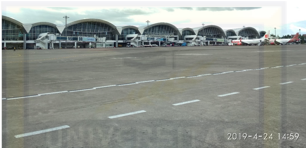
Gambar 2.2 Gedung terminal Bandara Internasional Sultan Hasanuddin
