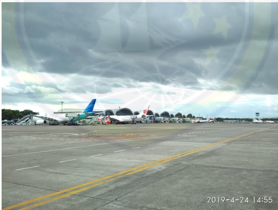
Gambar 2 Apron bandara Sultan Hasanuddin
