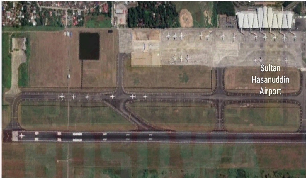
Gambar 2.3 Runway Bandara Internasional Sultan Hasanuddin
