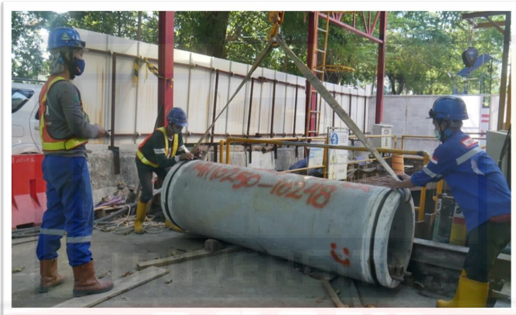
(Proses Pemasangan Instalansi pipa)
