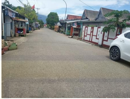
a) Jalan Aspal
