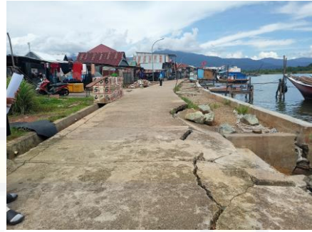
b) Jalan beton
