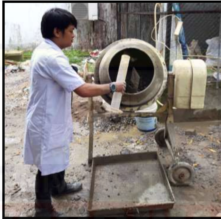
Gambar 11. Proses Pencampuran Beton
