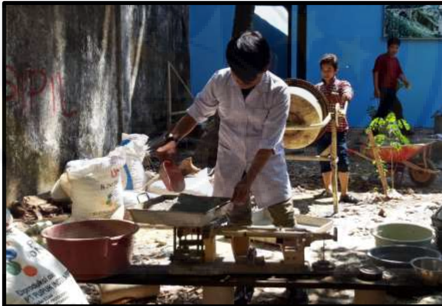
Gambar 10. Penimbangan Material Semen PPC
