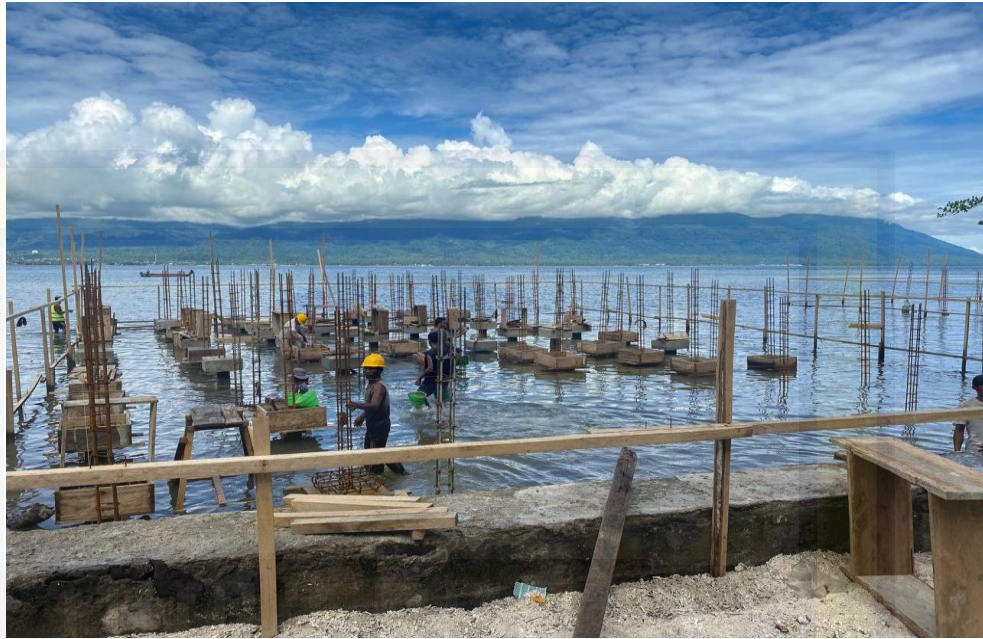
Gambar Pembangunan Restaurant dan Musholla Di Objek wisata Pulau Nusa Ra (16-07-2022)
