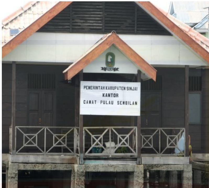
Gambar 4.2. Kantor Camat Pulau Sembilan di Pulau Kambuno.
