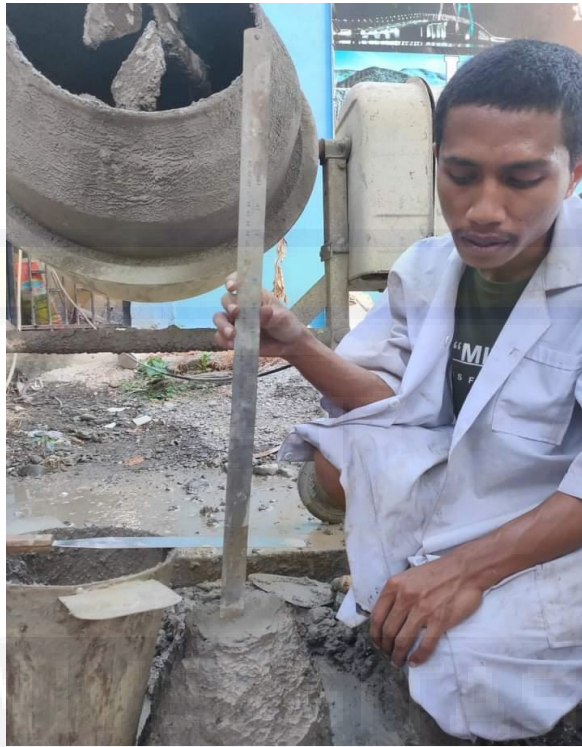
Gambar 5. Pengujian Slump Beton
