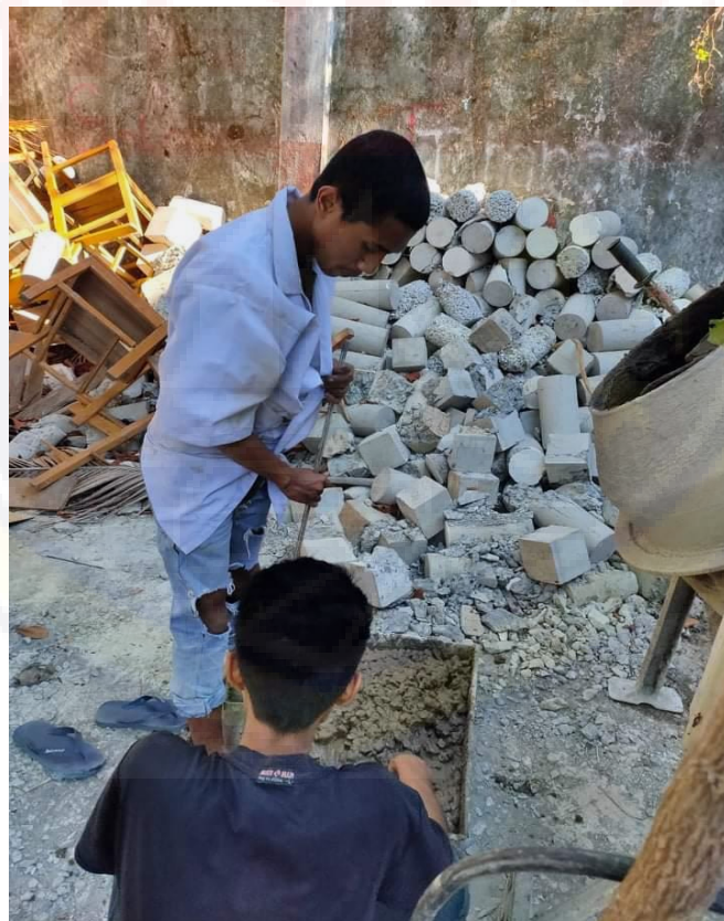
Gambar 6. Pemadatan Beton Dengan Cara Penusukan
