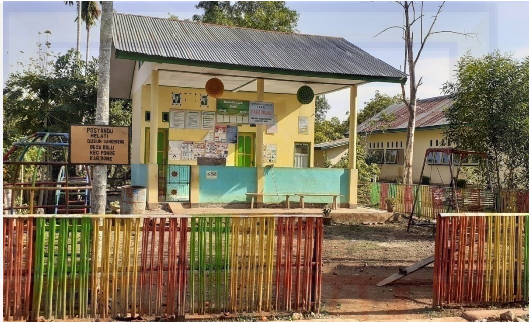
Realisasi pembangunan PAUD dengan melakukan renovasi di dusun sancereng
