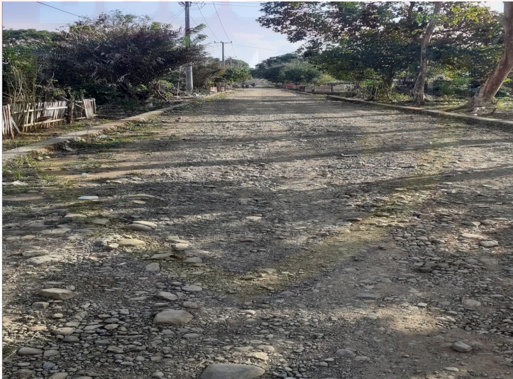
Realisasi pembangunan jalan desa di dusun maroanging
