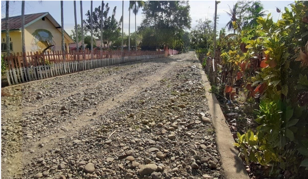
Realisasi pembangunan jalan desa di dusun sancereng
