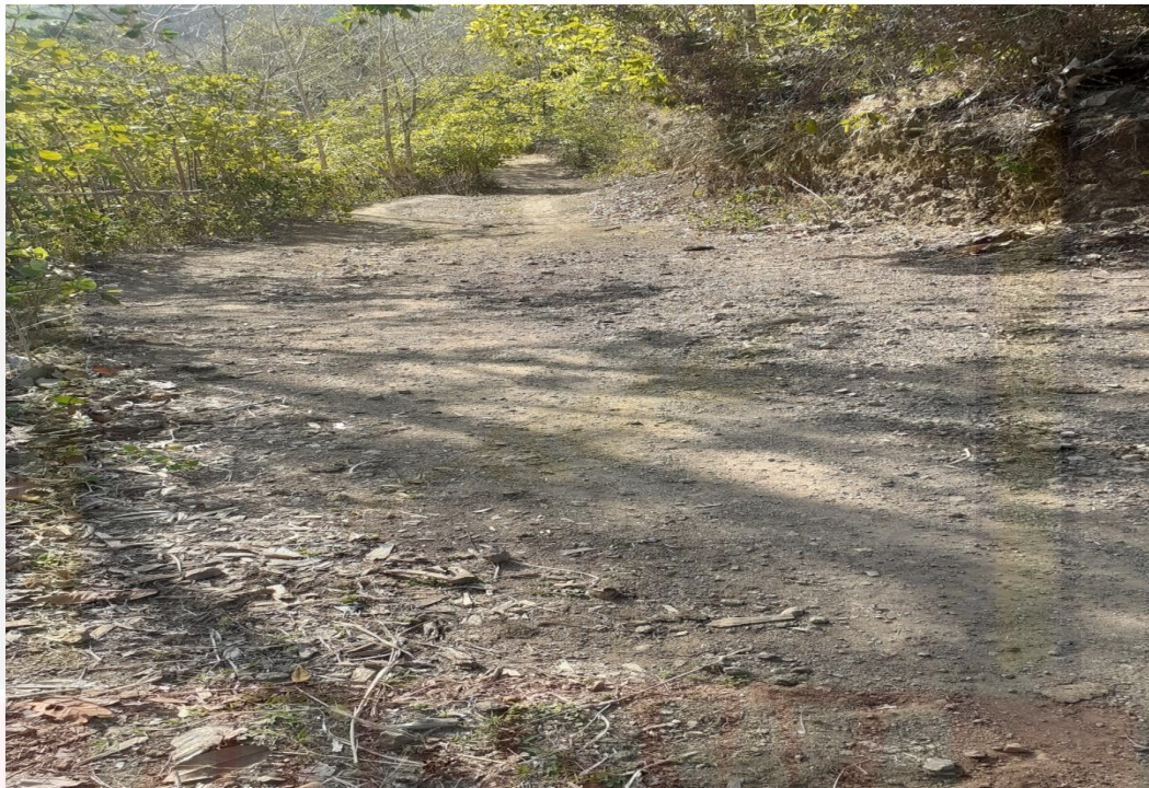
Realisasi pembangunan jalan tani di dusun barugae
