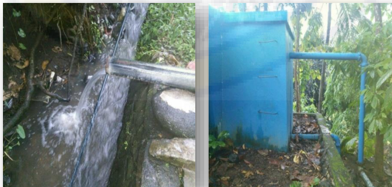
Gambar 4.11 Kondisi Jaringan PDAM
