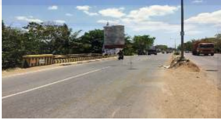
Dokumentasi Permukaan Aspal pada daerah Jembatan Berlubang
