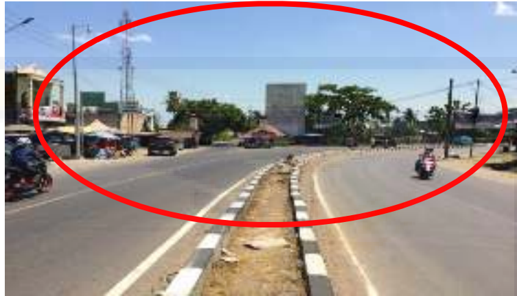
Gambar 3.4.7 Tidak terdapat Rambu – rambu
