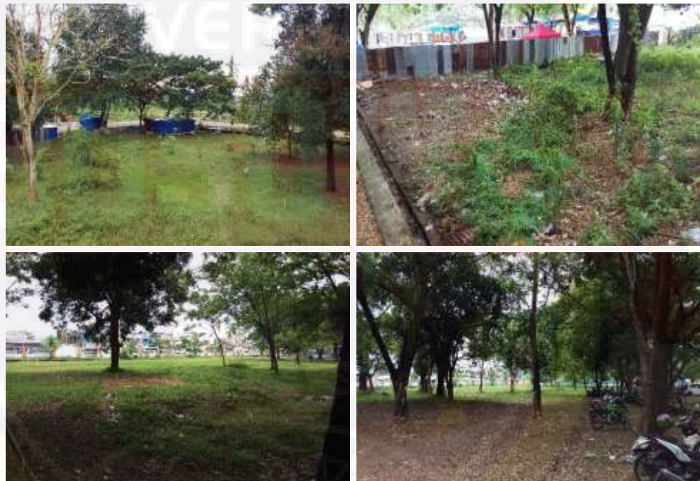
Gambar 3.13 : Landscape GOR Sudiang yang tidak difungsikan, sampah yang berserakan, tidak ada marka/garis parkir Sumber: Dokumentasi Penulis, 2017
