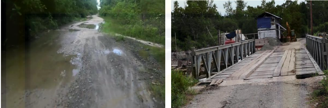
Gambar 4.16 Kondisi Jalan Menuju Obyek Wisata Pantai Papaliseran (Sumber Foto : Hasil Survey Lapangan 2019).
