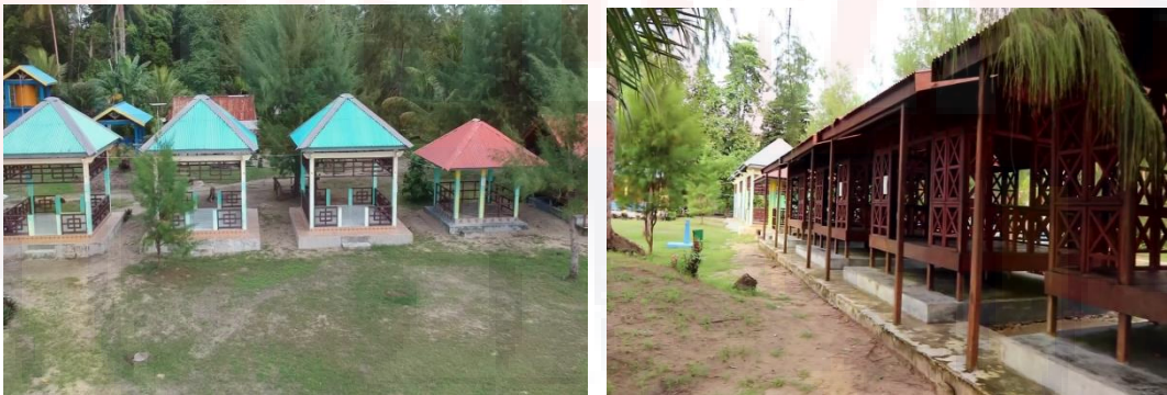
Gambar 4.9 Fasilitas Gazebo di Pantai Papaliseran (Sumber Foto : Hasil Survey Lapangan 2019).
