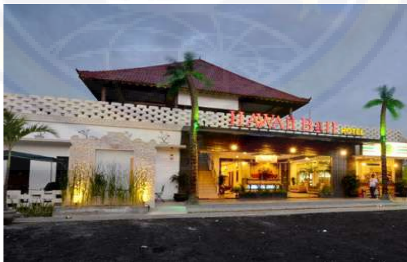
Gambar 2.4 Situasi Hawai Bali Hotel Sumber: Dokumentasi Penulis Tahun 2018
