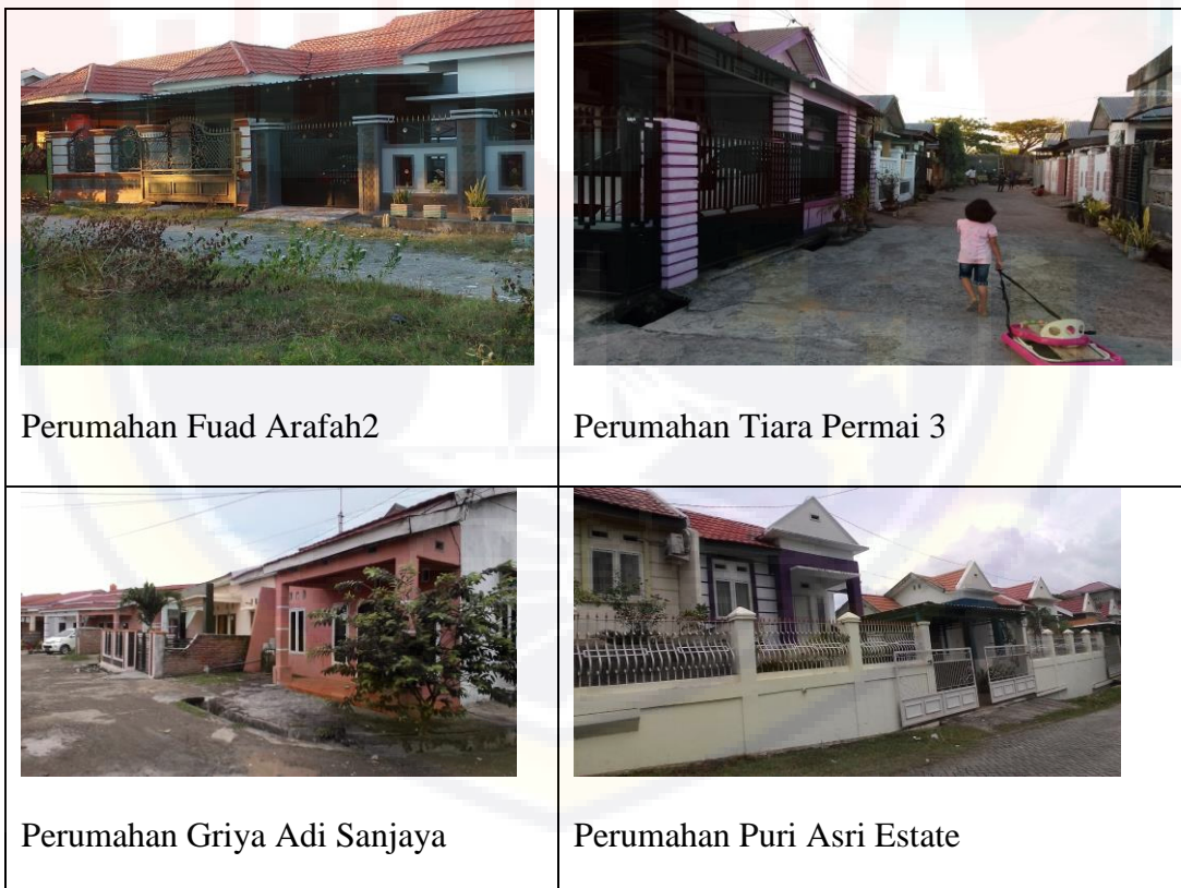
Gambar : 4.12 Kondisi Jalan Lingkungan Perumahan
